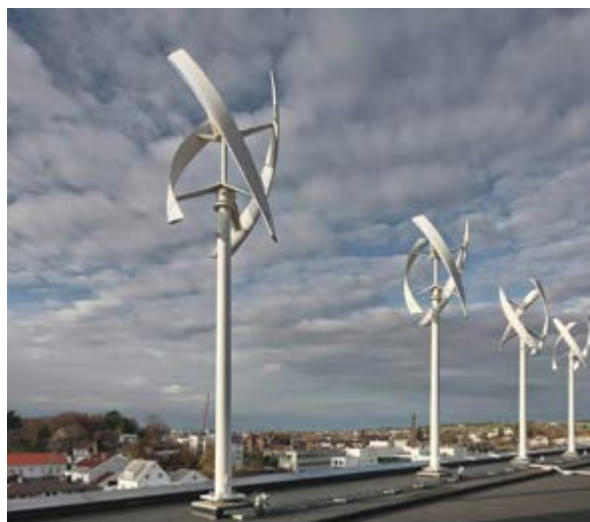
Figur 3.8 Vindturbiner (4 x 1 kW plassert på nye Bryne vgs (kilde Stavanger Aftenblad).
